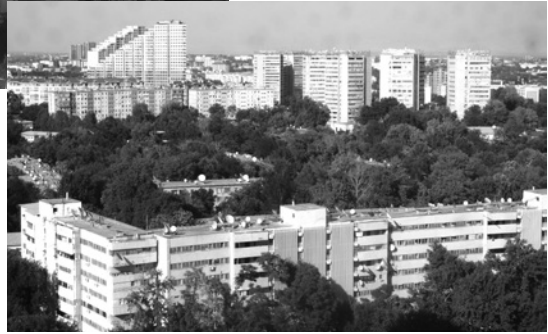
完工間近い「首都タシュケント・シティ改造計画」の市街地。高層ビルの半数ほどは中国系企業の手になるもの=7月11日撮影
